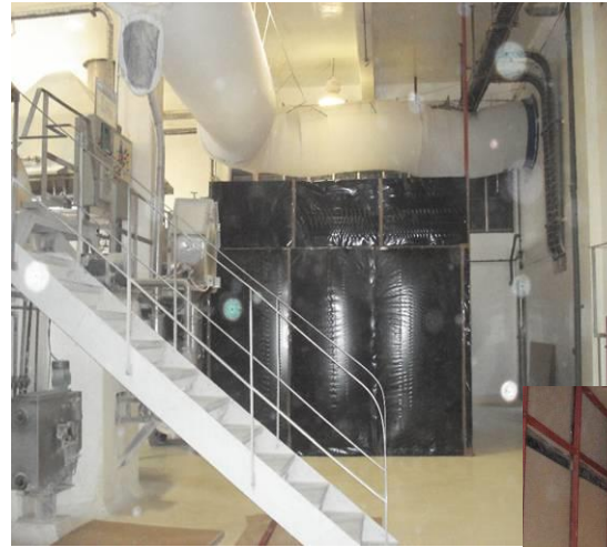
Cerramiento adecuado para trabajos de mantenimiento mayores
