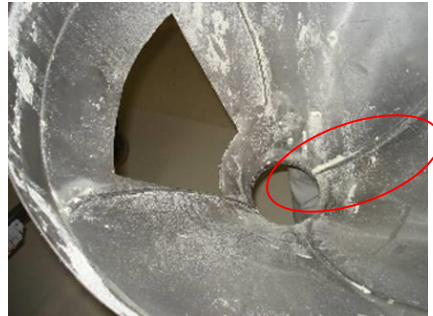
Deterioro en equipos (generación de partículas metálicas)
