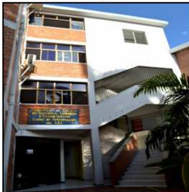
Edificio de Postgrado – Centro de Investigación del DAC
